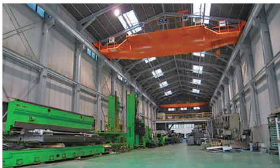
大阪営業所倉庫
